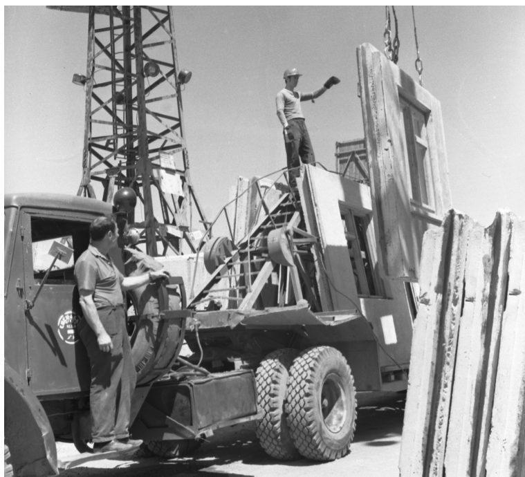
Фрунзенский ДСК. Погрузка наружных стеновых панелей на панелевоз на складе готовой продукции для отправки на стройплощадку. 1972. ЦГА КФД КР
